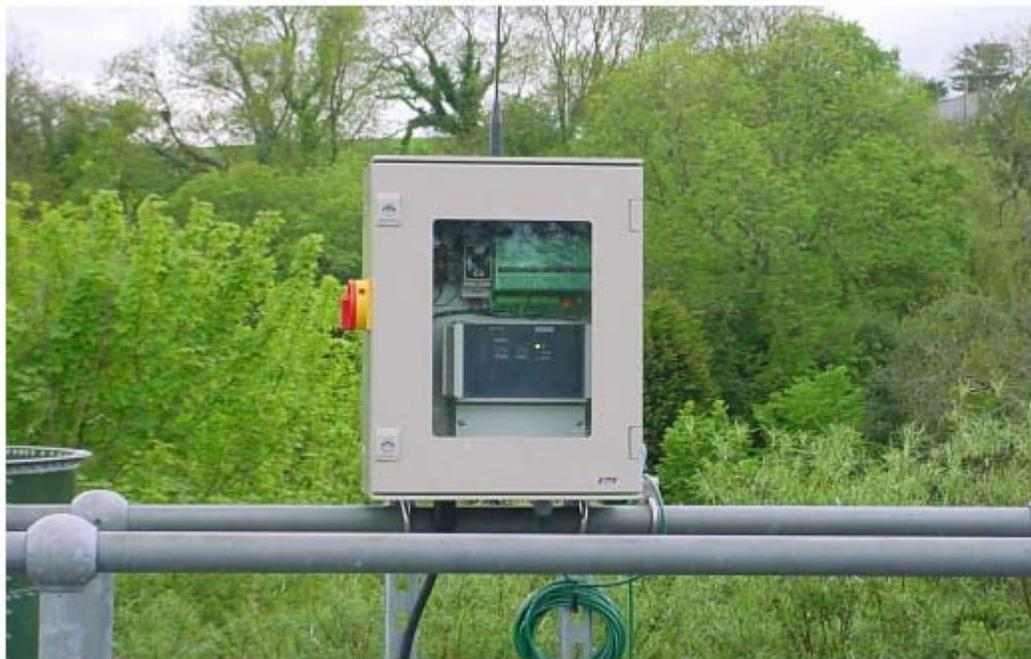
8100 监测仪能够可靠地探测澄清器与沉降池中的污泥界面，或多种流程中不断升高的悬浮固体水平或污泥密度。
