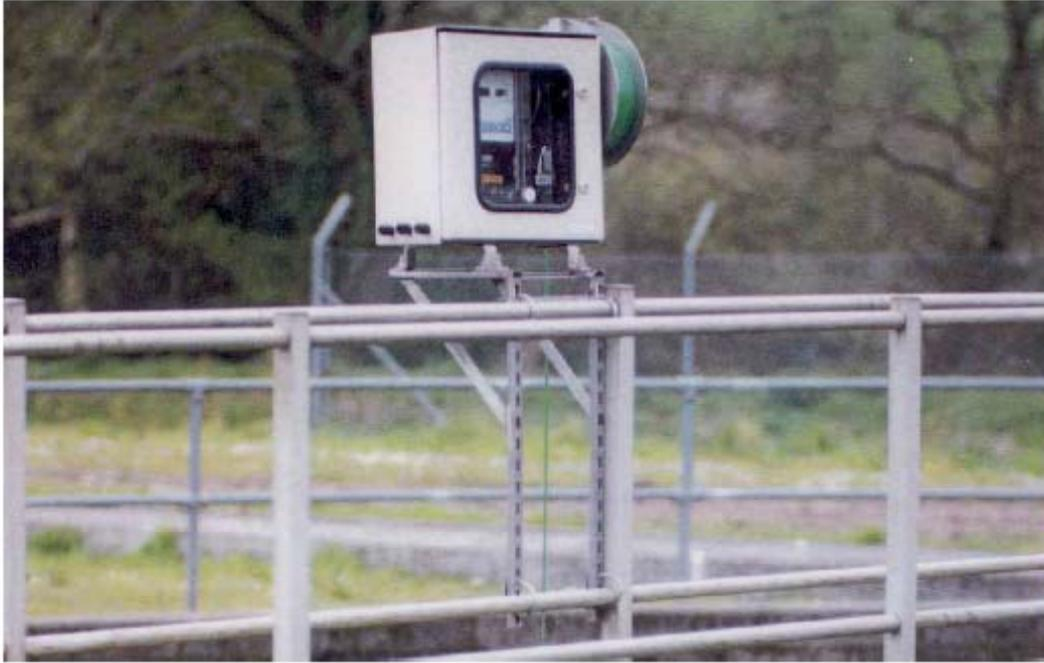
ASLD 2200 是一种全自动污泥界面探测器，主要用于水及污水工业，但也可用于其他类型的过程。它采用伺服系统驱动传感器，能够连续跟踪沉降界面，并产生 4-20mA 输出，后者与污泥层的深度成比例。
