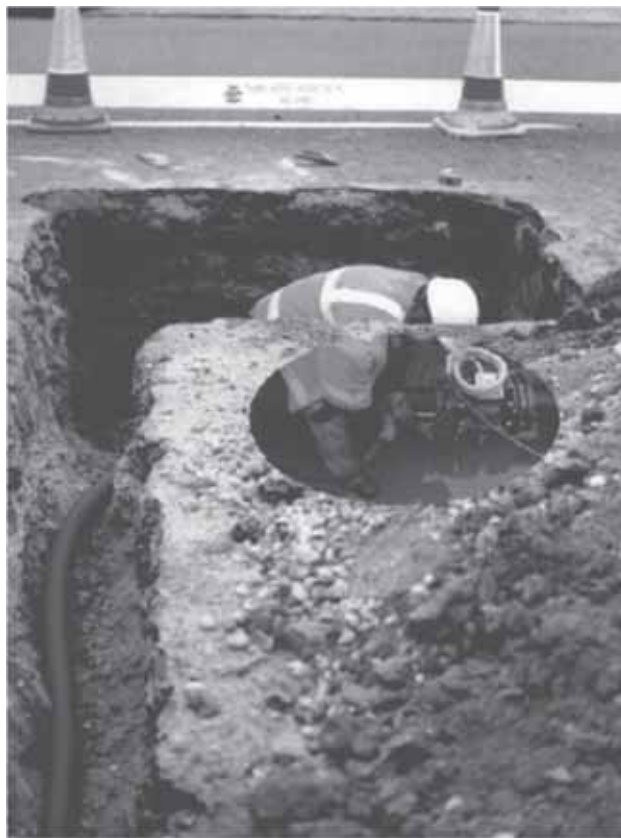
AquaMaster 的直埋式安装
